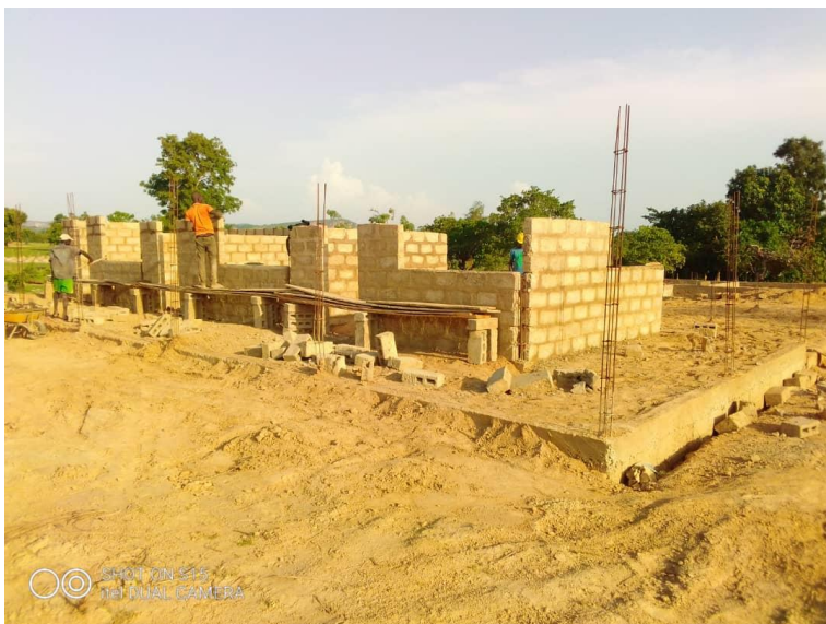
Der Rohbau wächst
