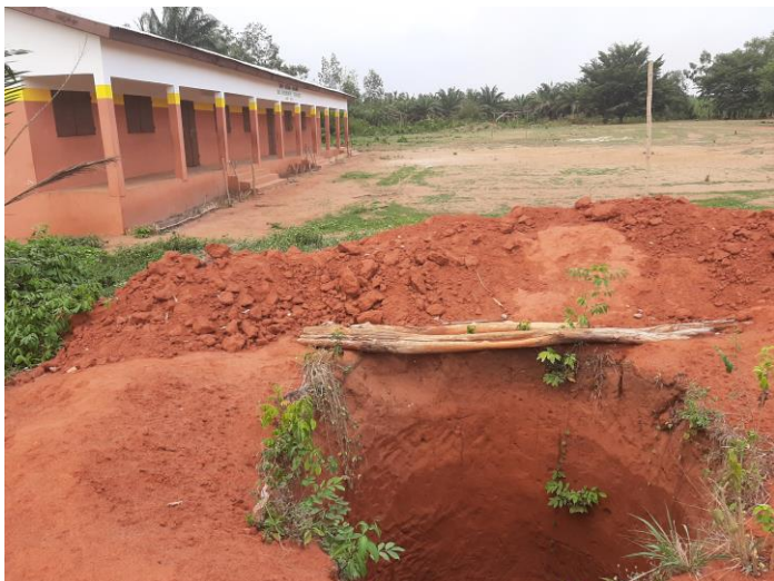
Grube für die neue Zisterne
